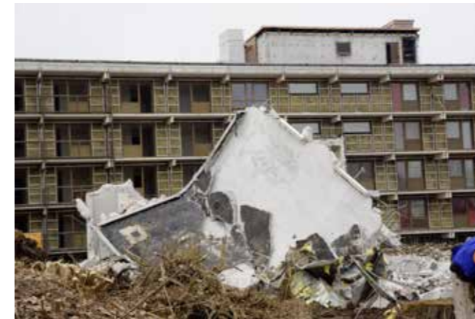
Hier schaffen Arbeiter Platz für neue Arbeitsplätze.
